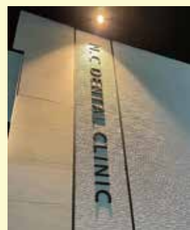
外部壁面サイン カルプ文字 LED 投光器
