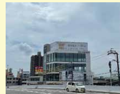
屋上サイン 枠 / 鉄骨 表示面インクジェット
