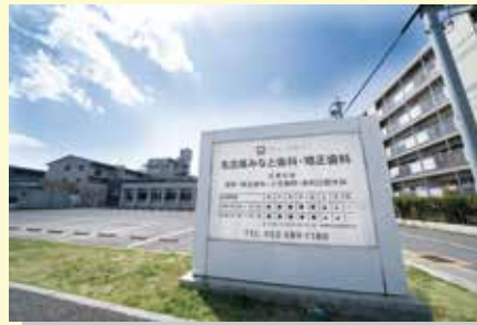
シンボルサイン 表示面アクリル + 枠 / 鋼板 文字 / カッティングシート LED 内照式
